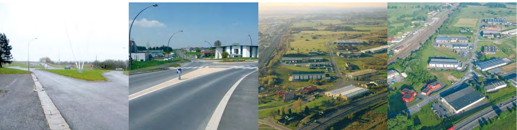
L'entrée de la zone avant (1) et après (2) les travaux de requalification. Vues aérienne de la zone avant (3) et après (4) les travaux de requalification.
