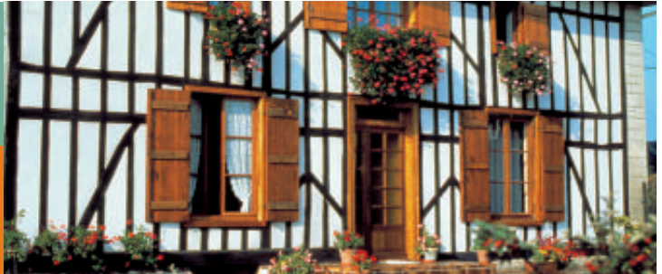
Maison à pans de bois
